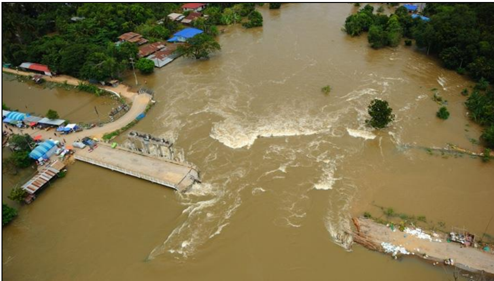
ภาพถ่ายความเสียหายบริเวณ ปตร.บางโฉมศรี ขณะเกิดอุทกภัย
