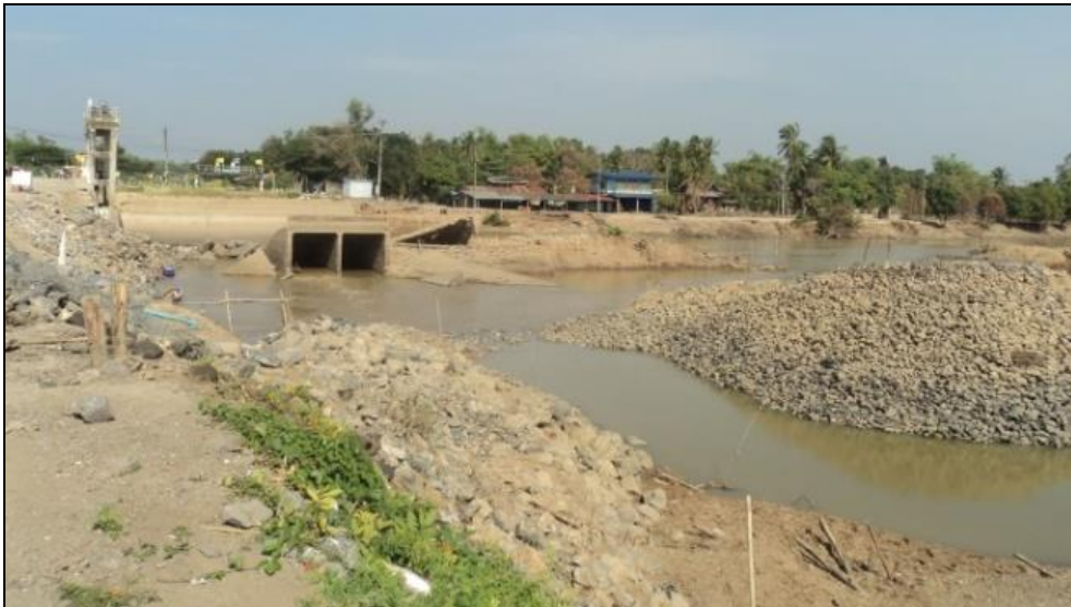
แสดงความเสียหายของอาคารไชฟอนบางโฉมศรี
