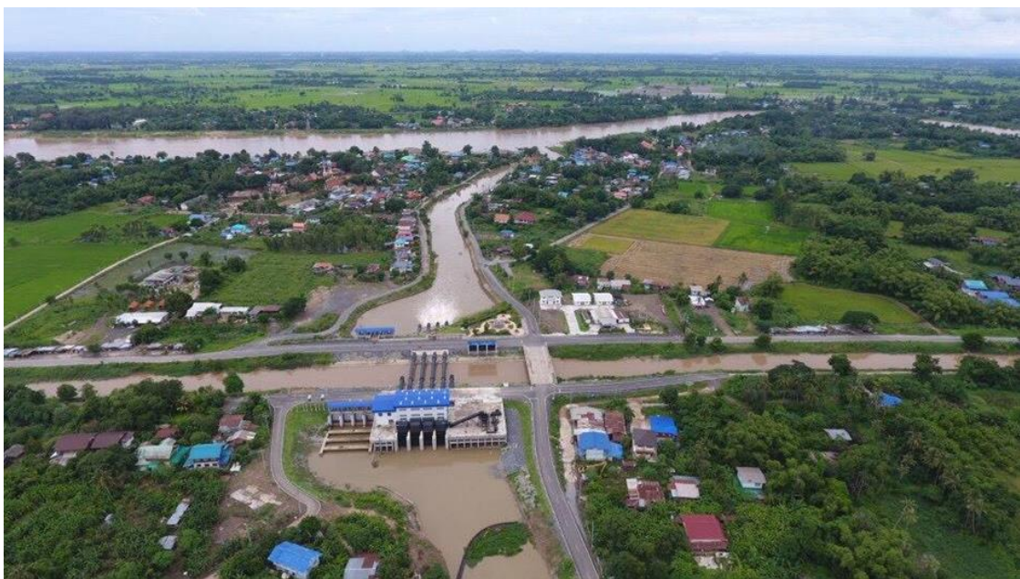
ภาพแสดงโครงการเพิ่มประสิทธิภาพการบริหารจัดการน้ำบริเวณประตูระบายน้ำบางโฉมศรี
