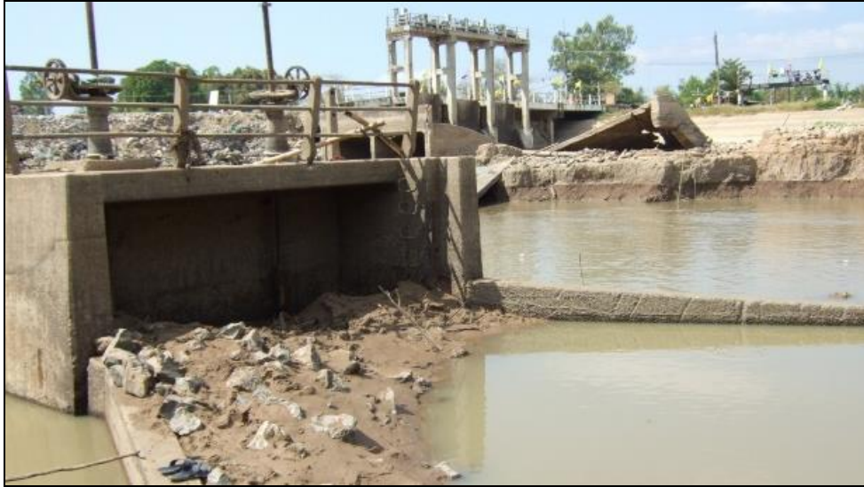
แสดงความเสียหายของอาคารไชฟอนคลองระบายใหญ่ ชัยนาท - ป่าสัก 2
