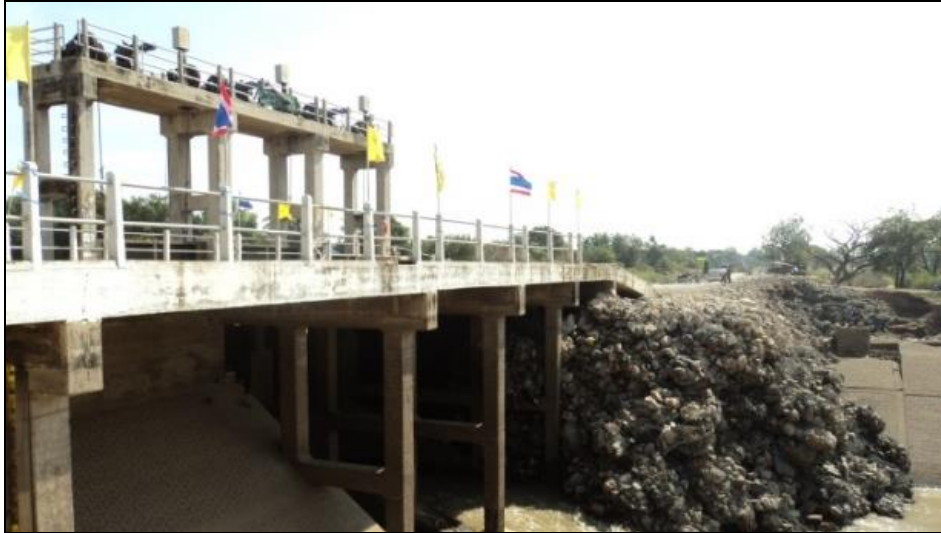
แสดงความเสียหายของอาคารประตูระบายน้ำบางโฉมศรี
